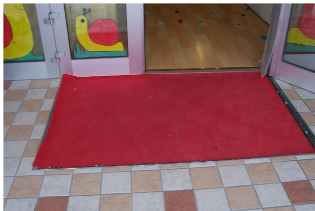
Elementi sporgenti accesso dettaglio
